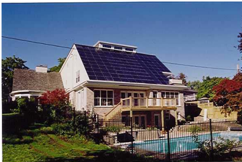
Photo 1: Exemple d'installation de BIPV
